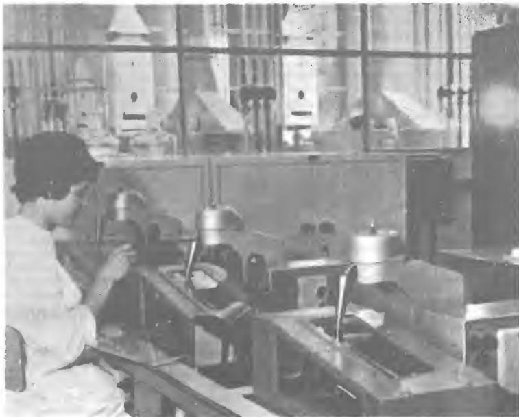
Fig. 1 - Selezione dello spessore dei cristalli di germanio.
