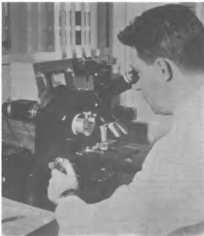
Fig. 7 - Controllo della geometria delle giunzioni nei transistor Philips di bassa frequenza.
