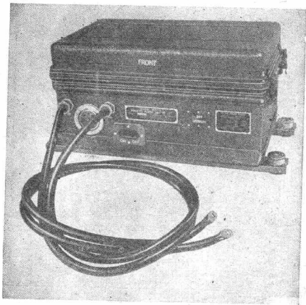
Slika 8. — Vibratorski pretvarač
