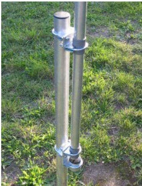
**L'antenne ITA OTURA est constituée par la mise en service de 5 brins emboîtés les uns dans les autres. L'élément du bas est livré prémonté avec son MTFT, les grosses plaques en PVC et les brides. Le montage consiste à vérifier le serrage des vis, écrous et boulons déjà en place puis d'emboîter les 4 tubes.**
