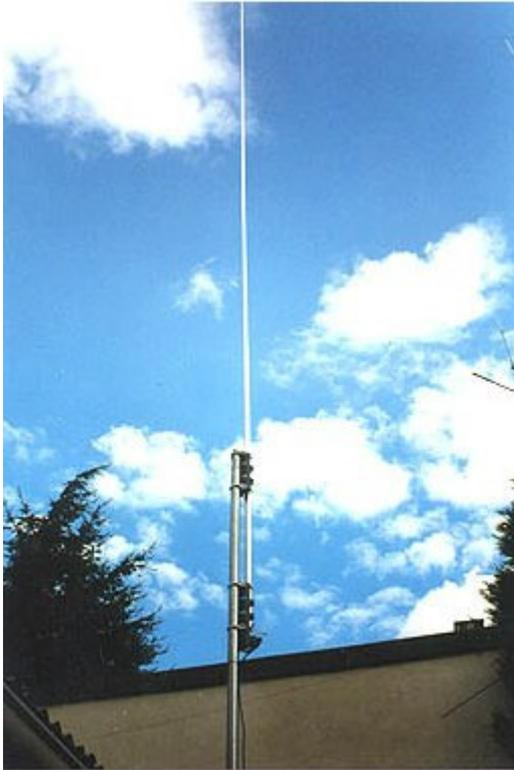
Elle est facile à monter et sa mise en service reste d'une grande simplicité. Les aficionados du montage sur cheminée prendront une attention particulière à l'installation. Si l'antenne est montée au bout d'un tube de plus de 3 mètres de haut, il y a fort à parier que le haubanage s'imposera.
