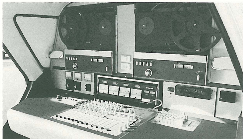
Gesamtansicht des Kontrollraums
