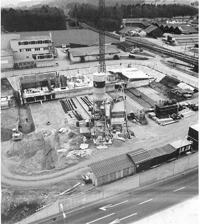
Nach einer kurzen Winterpause wurde die Arbeit am Neubau wieder aufgenommen. In der Zwischenzeit ist das 2. Untergeschoss fertiggestellt.
