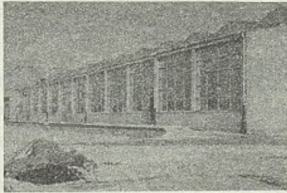
Fot.1. Widok nowowybudowanego magazynu
