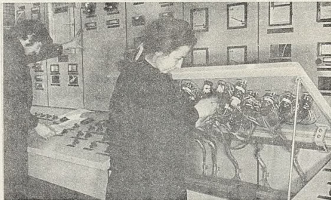
Fot. 2. Fragment szafy sterowniczej cukrowni
