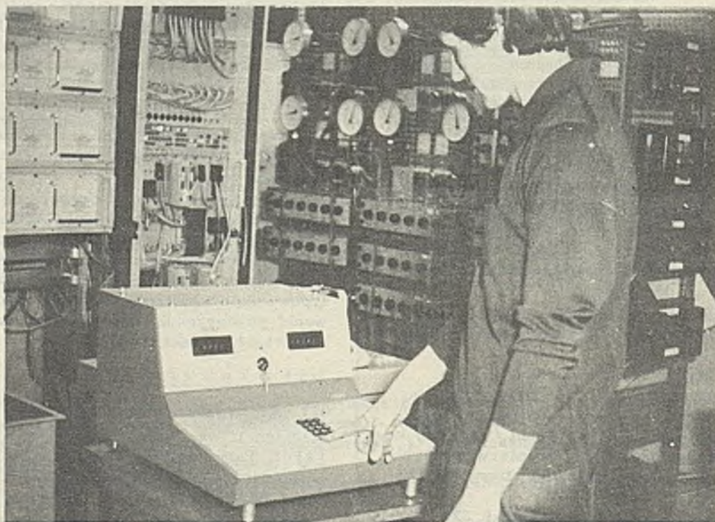
Fot. 1. Nadajnik klawiaturowy podczas prób makietowych
